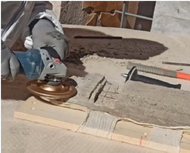
Assottigliamento del supporto cementizio e rimozione della struttura metallica
