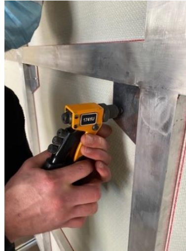
Preparazione dei nuovi supporti
