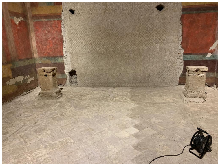
Casa di Augusto – Rimozione depositi incoerenti con aspirapolvere
