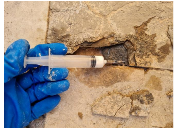
Opus sectile in ardesia e marmo bardiglio Consolidamento esfoliazione, incollaggio lastre fratturate e riallettamento
